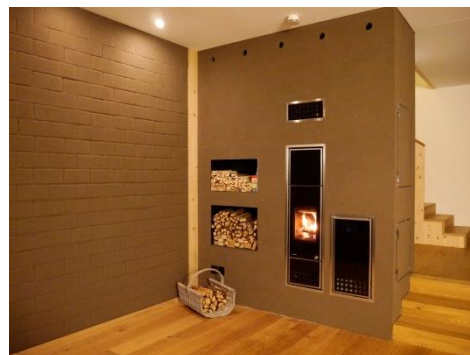
Der Kombi-Zentralheizungseinsatz Aqua-Insert mit 9.3 kW Gesamtheizleistung beheizt das EFH-Haus in Kombination mit 2 Oertli FL 230H Solarkollektoren. Foto unten die Anlage im «Rohbau», vor dem Lehmverputz.
