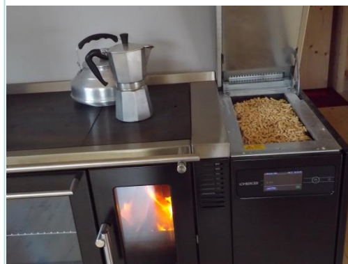
Der Lohberger Kombi-Zentral-Heizungsherd Holz/Pellets mit 7 kW Leistung. 70% der erzeugten Wärme gibt der Herd an den Kombi-Speicher ab, 30% in den Raum - und sorgt für ein angenehmes Wohnklima.
