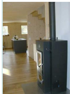
Beheizt mit Walltherm Königsspitze, Naturzug-Zentralheizungsofen mit 93,5 % Wirkungsgrad. VHe 0142.
