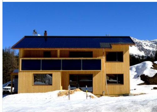
Das neue Ruwa-Holzhaus der Familie Bruderer in Davos Laret mit 4 fassaden-seitigen Solarkollektoren. (Nutzfläche 10 m 2 ) und der Photovoltaikanlage auf dem Dach.
