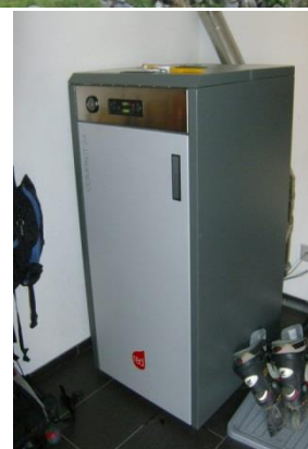
MCZ RED Compact 24 Pellet-Zentralheizung im Eingangsbereich.
