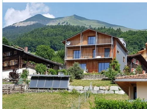
EFH Baujahr 2007 / Minergie-P-Standard
