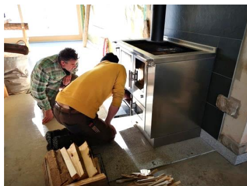
Der Bauherr und Monteur Matthias Jecklin beim Einfuern des Sturzbrandherdes.
