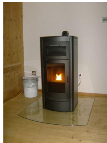
MCZ Musa Pelletzentralheizungsofen mit 2.5 – 15,4 kW Heizleistung als Ergänzung der Solaranlage. Der Ofen ist mit dem Zertifikat der Holzenergie Schweiz versehen. Vhe 0150. (Fördergeldberechtigt)
