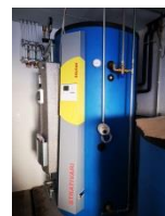
Nebenraum mit einem Kombi- und einem zusätzlichen Brauchwasserspeicher.
