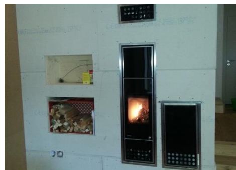
Der Kombi-Zentralheizungseinsatz Aqua-Insert mit 9.3 kW Gesamtheizleistung beheizt das EFH-Haus in Kombination mit 2 Oertli FL 230H Solarkollektoren. Foto unten die Anlage im «Rohbau», vor dem Lehmverputz.
