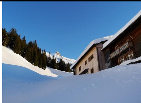
Stallsanierung mit Einbau einer Wohnung.
