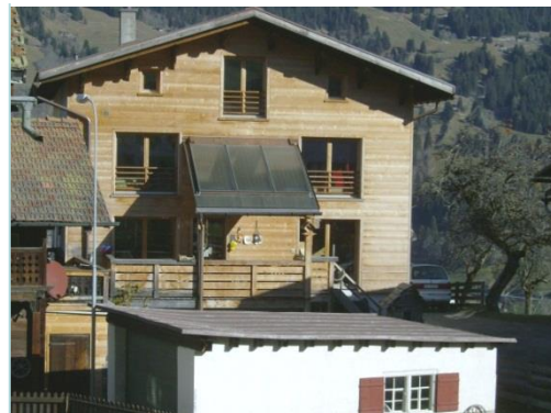
3 Flachkollektoren unterstützen den Lohberger Holz-Zentralheizungsherd sowie die kontrollierte Lüftung.
