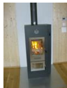
Beheizt mit Walltherm Königsspitze, Naturzug-Zentralheizungsofen mit 93,5 % Wirkungsgrad. VHe 0142.
