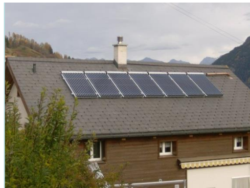
7 hocheffiziente AMK OWR Vakuum-Röhrenkollektoren versorgen den Vier-Personen-Haushalt mit der Solar-Grundenergie.
