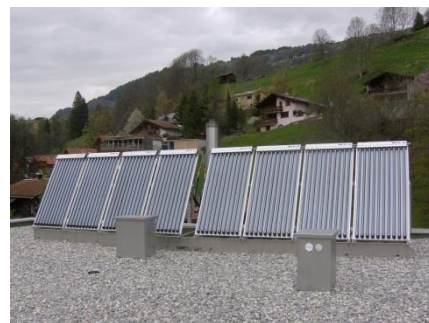
Die Solaranlage mit 10 kW Gesamtleistung deckt ca. 1/3 des Energiebedarfs!
