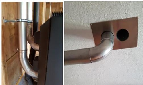
Bei der Installation wurde Rücksicht auf das unter Heimatschutz stehende Gebäude genommen. Die alten Holzwände und Decken wurden nach Möglichkeit von Holzdurchbrüchen verschont und die Warmluft über einen EI 90 - Luftkanal im Estrich und der Decke geführt.
