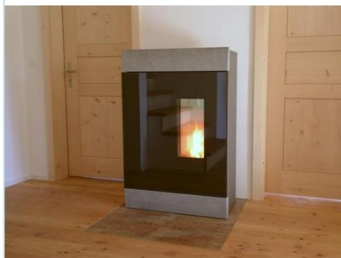
Das „Kernstück“ der Heizanlage, der Pelletofen Rika Roco mit Warmluft-Verteilung. Kaminanschluss, Frisch-Luftzufuhr und Warmluftverteilung diskret verlegt.
