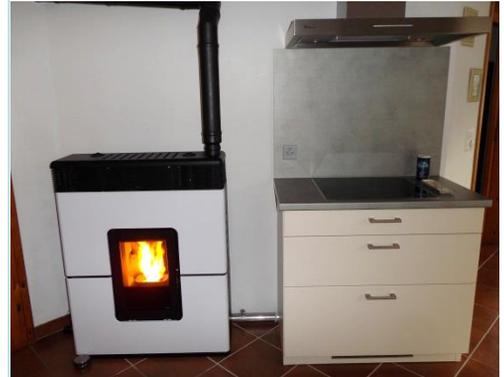
Ansicht nach dem Küchenumbau. Ein Warmluftabgang wurde durch die Küchenkombination gelegt, damit wird die warme Luft in die Ess-Ecke geleitet.
