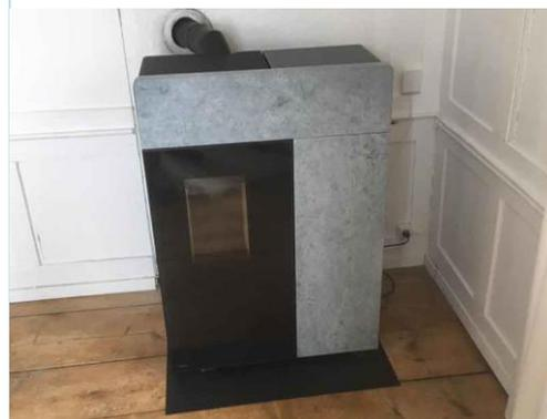
Die beiden Rika Domo Multiair Pelletöfen mit Specksteinverkleidung beheizen über die hausinterne Warmluftführung weitere Räume. Über WLAN von auswärts steuerbar. .
