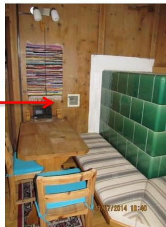
Kleine eckige und runde Auslassgitter decken die Warm-Luftausgänge ab, durch welche die wohlige Wärme strömt.
