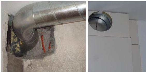
Seitliche Ansicht nach Montage-Abschluss mit Ansicht der Rauchrohr-Führung sowie Küchen-Kombinations-Einbau. Unten rechts der Warmluft-Ausgang in der Kombination.
