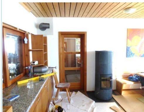
Der Kaminanschluss ist vorbereitet, der Ofen mit einem Gewicht von 545 kg steht. Noch das Rauchrohr montieren, sicherheitshalber erst auf den neuen Ofen anstossen - und danach „Probefeuern“.
