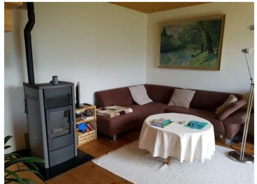
Der Pellet Zentralheizungsofen MCZ Ego Hydro ersetzt einen vorgängigen Holz-Zentralheizungsofen.
