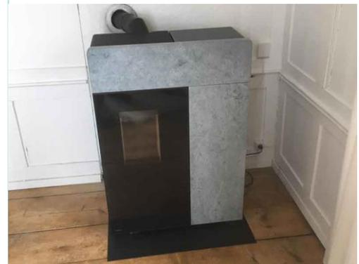
Die beiden Rika Domo Multiair Pelletöfen mit Specksteinverkleidung beheizen über die hausinterne Warmluftführung weitere Räume. Über WLAN von auswärts steuerbar. .
