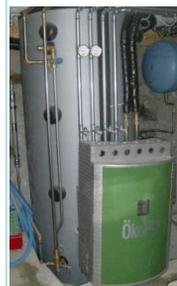
ÖkoFEN-Multi-Express Schichtlade-Wärmespeicher Pellaqua mit 1000 ltr für Brauch- und Heizungswasser mit Solar-Thermikwärmetauscher und Trinkwasser-Zirkulationslanze.
