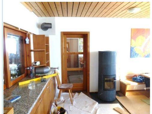
Der Kaminanschluss ist vorbereitet, der Ofen mit einem Gewicht von 545 kg steht. Noch das Rauchrohr montieren, sicherheitshalber erst auf den neuen Ofen anstossen - und danach „Probefeuern“.
