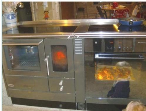
Die Küche ist offen zum Esszimmer und gibt somit direkte Wärme in den Raum. Oberhalb des Ofens befindet sich die Lüftungsöffnung der kontrollierten Lüftung welche die warme Luft ansaugt.
