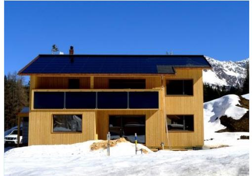
Das neue Ruwa-Holzhaus der Familie Bruderer in Davos Laret mit 4 fassaden-seitigen Solarkollektoren. (Nutzfläche 10 m<sup>2</sup>) und der Photovoltaikanlage auf dem Dach.
