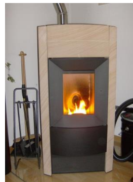
Der Ofen fand in einer Ecke Platz, der Rauchabgang erfolgt durch eine Kaminanlage im Schrägdach.
