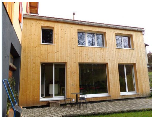
Wohnhaus-Anbau im Minergie-Standard. Holzkonstruktion, innen mit Lehmwänden ausgelegt zur Wärme-Regulierung.
