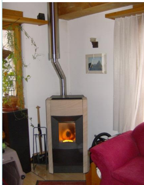
Mit diesem Pelletofen werden 92 m 2 Wohnfläche auf 22 Grad beheizt, mit 300.00 CHF Heizkosten im Jahr!
