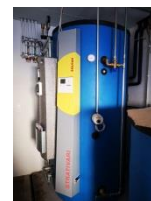
Nebenraum mit einem Kombi- und einem zusätzlichen Brauchwasserspeicher.
