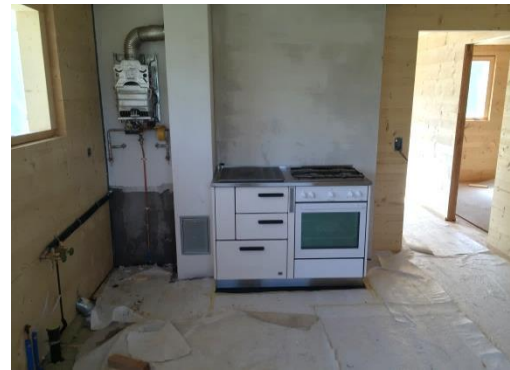
Bei schönstem Wetter erfolgte die Kamin-Montage (EI 90 Schacht) für den Herd.
