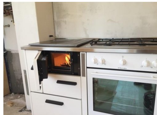
Einbringung der Tiba-Herd-Kombination Holz – Gas, mit anschliessendem Brenn-Test.
