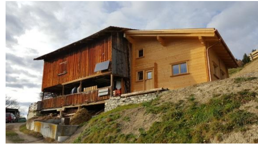
Neuer Anbau am Maiensäss Malfeis oberhalb Küblis auf 1400 m ü.M.
