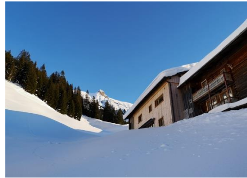
Stallsanierung mit Einbau einer Wohnung.
