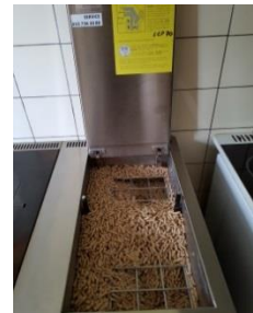
Pellet-Tank ca. 20 Kg Fassungsvermögen
